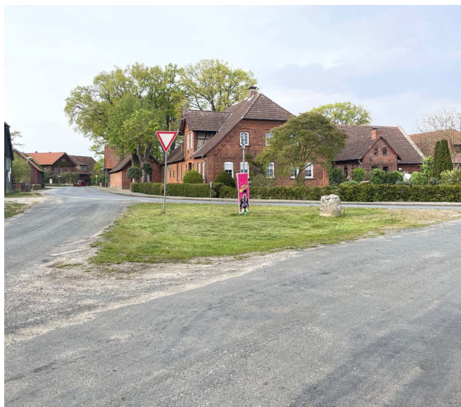
Abb. 23: Wiedenroder Straße in Böckelse als Beispiel für dringend sanierungsbedürftige Straßen in der Gemeinde
