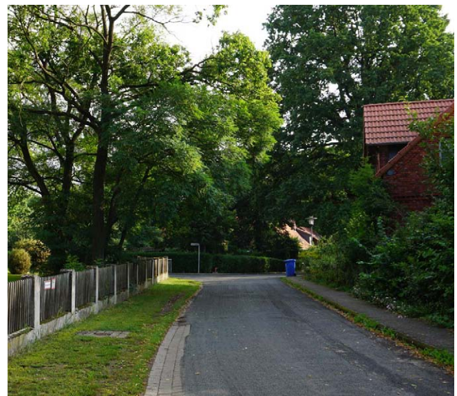
Abb. 24: Die Bordsteine in Pässe sind größtenteils nicht abgesenkt und daher nicht barrierefrei
