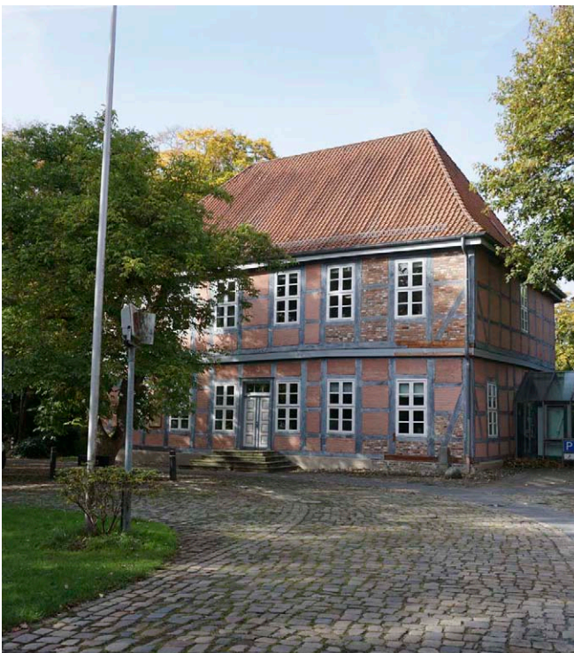
Abb. 26: Verwaltungssitz der Samtgemeinde Meinersen im ehemaligen Amtsschreiberhaus
